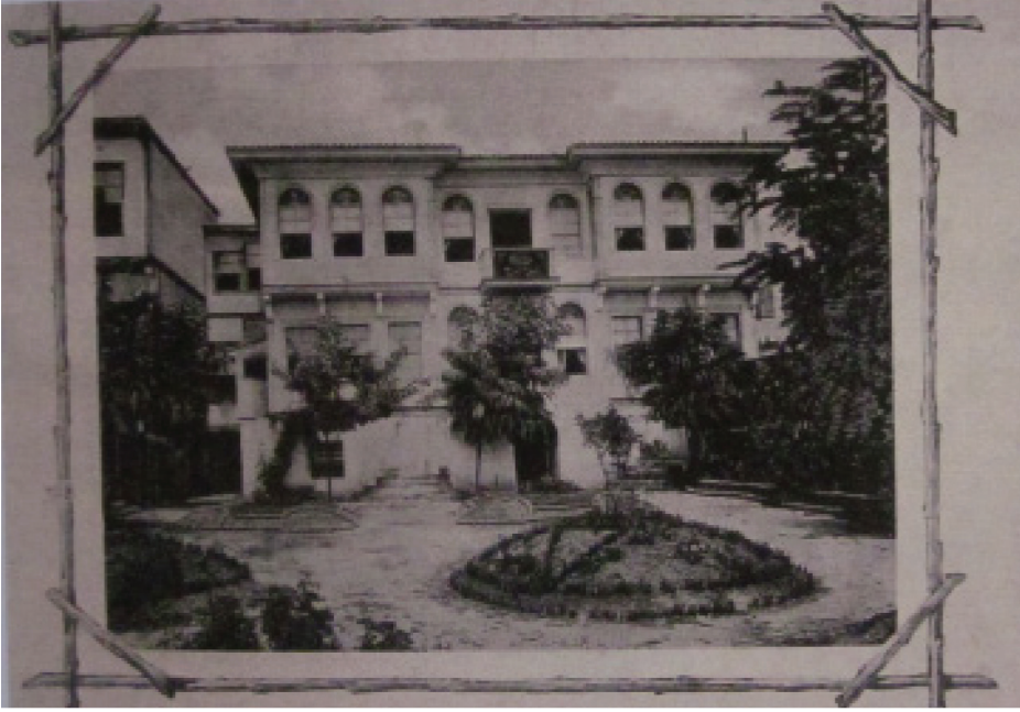
Selanik'teki Fezviye Mektebi Kızlar Bölümü Binası
