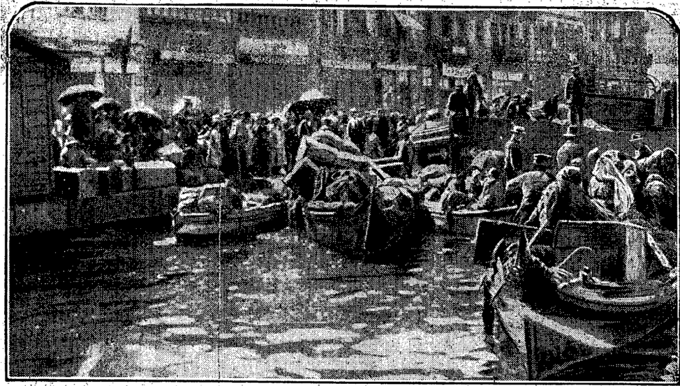
LE PORT DE SMYRNE ENCOMBRÉ DE RÉFUGIÉS
